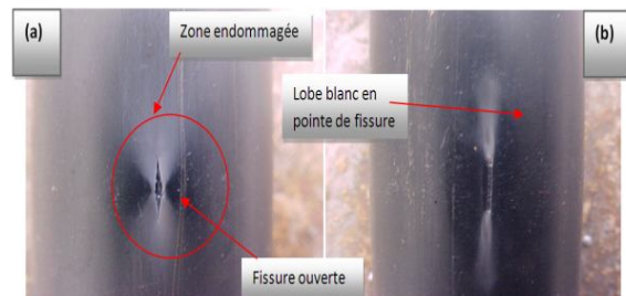
Figure 7 : faciès de rupture après essais d'éclatement des éprouvettes moyennement et fortement impactées (a) tube impacté H = 1.3m (b) H = 1m
