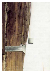
Fig. 1. Renforcement d'un pied de poteau par des plaques en acier
