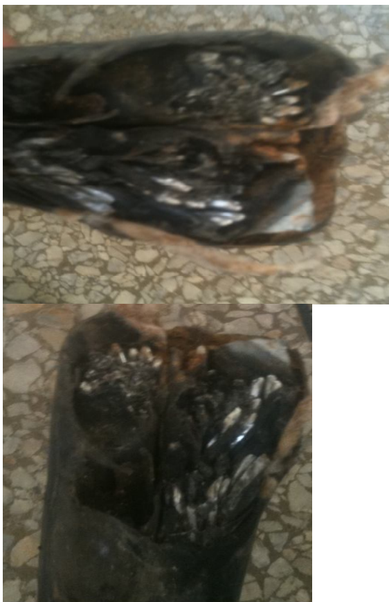
Figure 3 : Sur intensité d'un câble électriques souterrains BT. [3].
