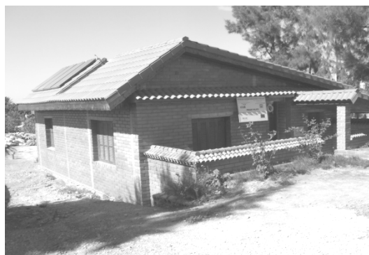
Fig.1 : La maison prototype située au CNERIB de Souidania, Alger.
